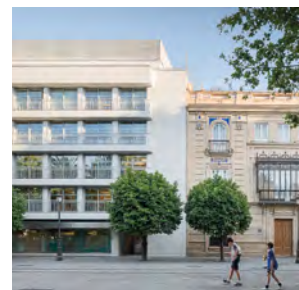
Rehabilitación de Fachada Miguel Blázquez Arquitectos SLPU Fotografía: Juanca Lagares
