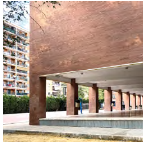
Reforma de fachada y acerado en IES Nervión José Delgado Diosdado Fotografía: José Delgado Diosdado
